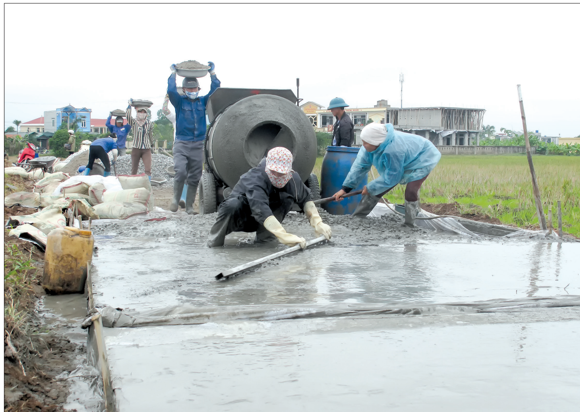
Hết năm 2017, toàn tỉnh đã xây dựng và nâng cấp 3.539km đường giao thông nội đồng.
