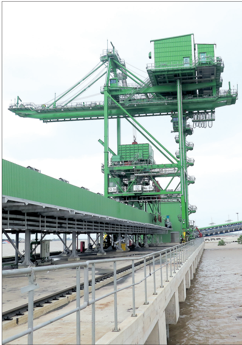
Dự án Nhà máy nhiệt điện Thái Bình tại xã Mỹ Lộc (Thái Thụy).
