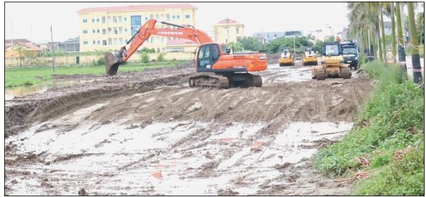
Thi công đường 221A đoạn qua địa phận thị trấn Tiến Hải (Tiến Hải).
