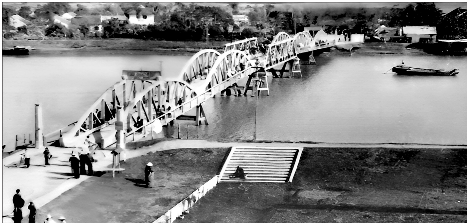
Cầu Bo bị giặc Pháp nổ mìn đánh sập một nhịp vào 17 giờ ngày 30/6/1954.
