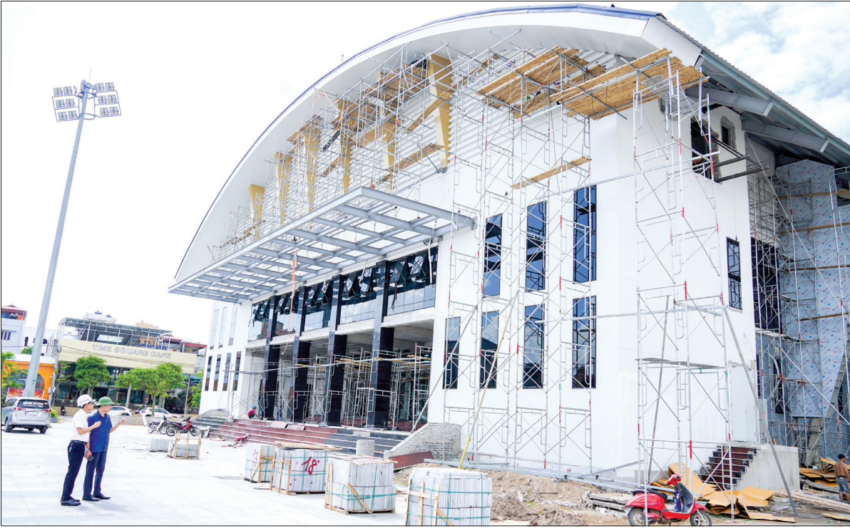
Công trình Trung tâm Văn hóa Thể thao huyện Thái Thụy (giai đoạn 2) đã hoàn thành 97% khối lượng.
