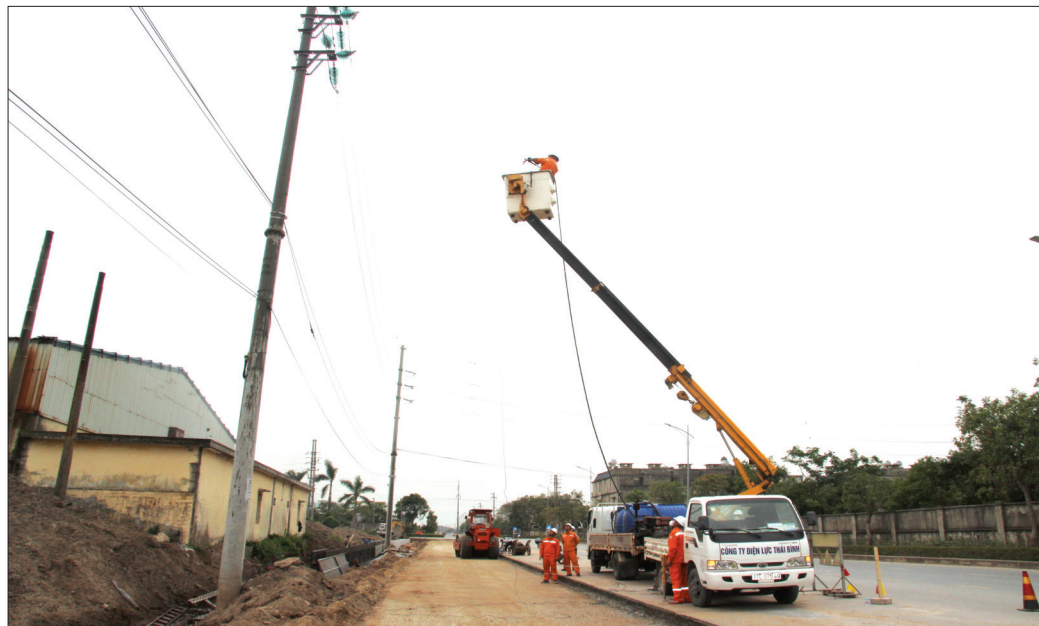
Điện lực Tiền Hải thực hiện rửa vệ sinh sứ tại khu công nghiệp Tiền Hải.
