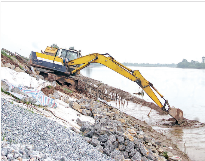
Thi công kè Tổng Thô từ k33+400 đến k33+600 đê tả Trà Lý, đoạn qua địa phận xã Đông Mỹ, thành phố Thái Bình.
