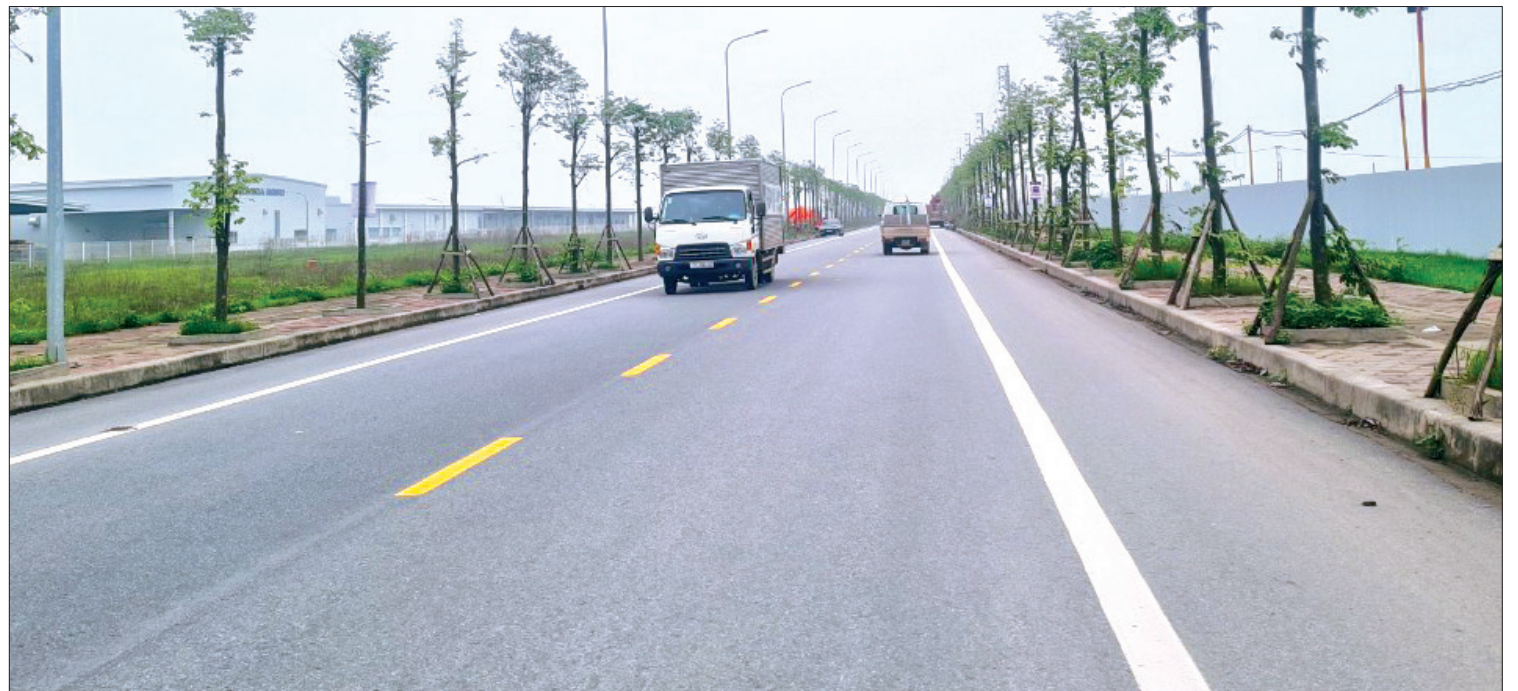
Hạ tầng khu công nghiệp Tiên Hải được đầu tư đồng bộ.
