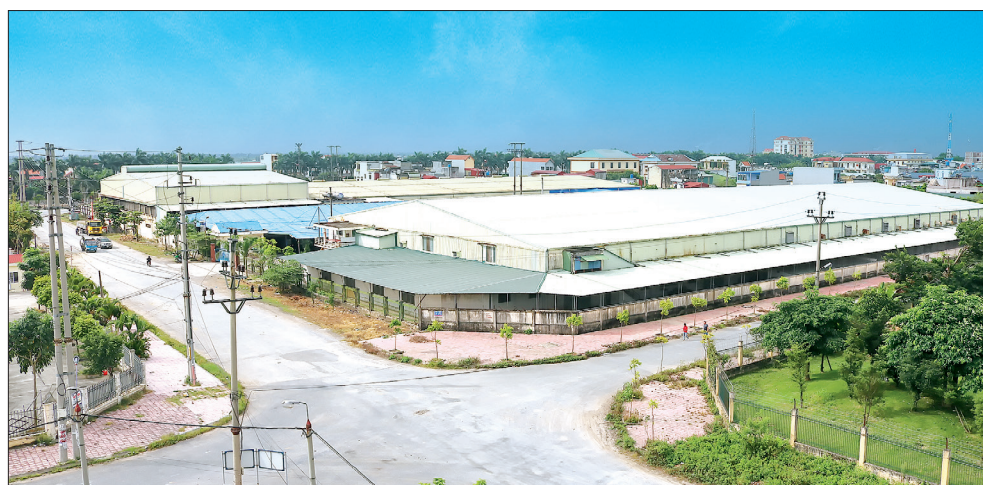
Cụm công nghiệp thị trấn Vũ Thư đầu tư hơn 100 tỷ đồng hoàn thiện cơ sở hạ tầng, thu hút 7 dự án đầu tư sản xuất, kinh doanh.
