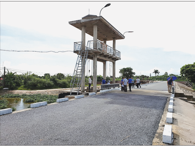
Công trình nâng cấp cống Hệ tại K16+150, đê hữu Hòa (Thái Thụy) vừa được nghiệm thu, bàn giao đưa vào sử dụng, góp phần bảo đảm an toàn phòng, chống lụt bão.
