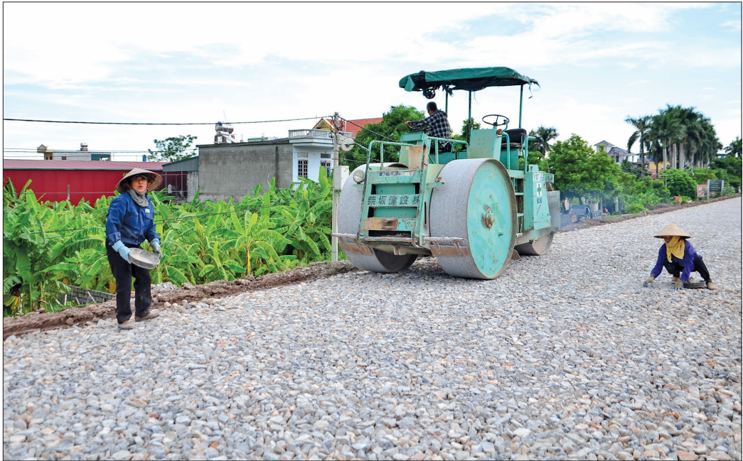
Đơn vị thi công triển khai các hạng mục công trình xử lý cấp bách một số tuyến kè sạt lở và củng cố hóa mặt đê tại những điểm xung yếu thuộc tuyến đê tả Trà Lý đoạn qua thành phố Thái Bình.
