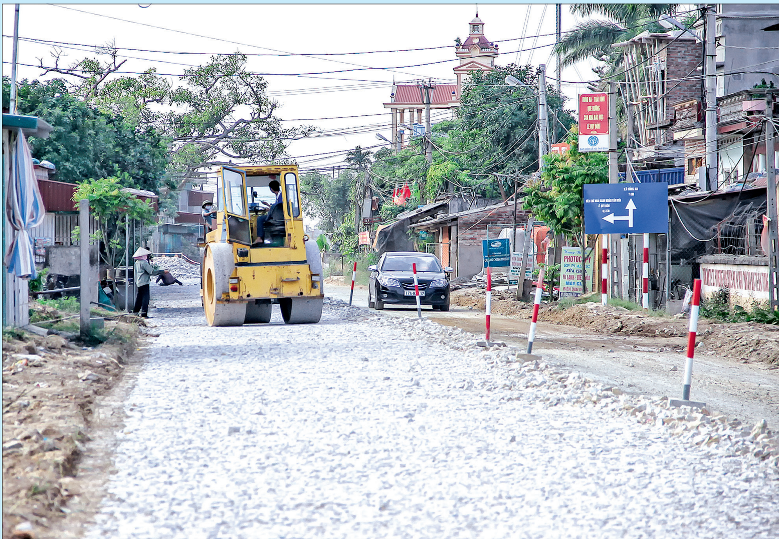
Thi công đường tỉnh ĐT.453 đoạn qua địa phận xã Độc Lập (Hưng Hà).
