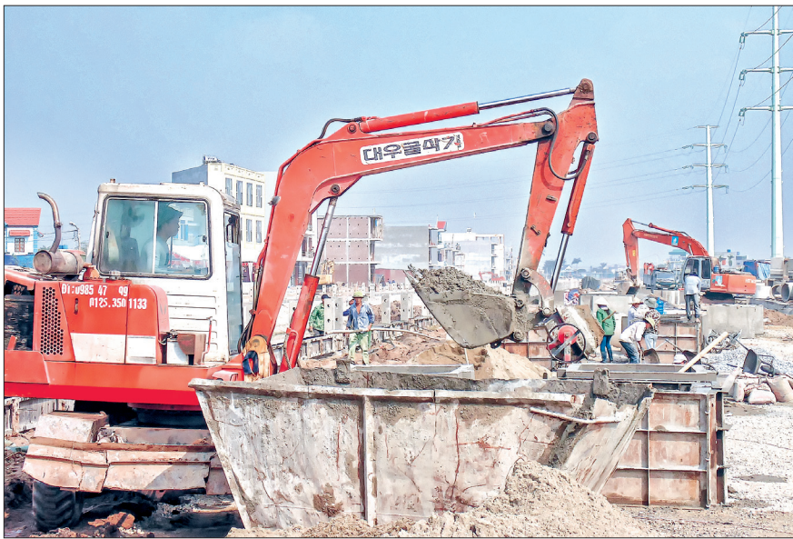
Đẩy nhanh tiến độ thi công Quảng trường Thái Bình.
