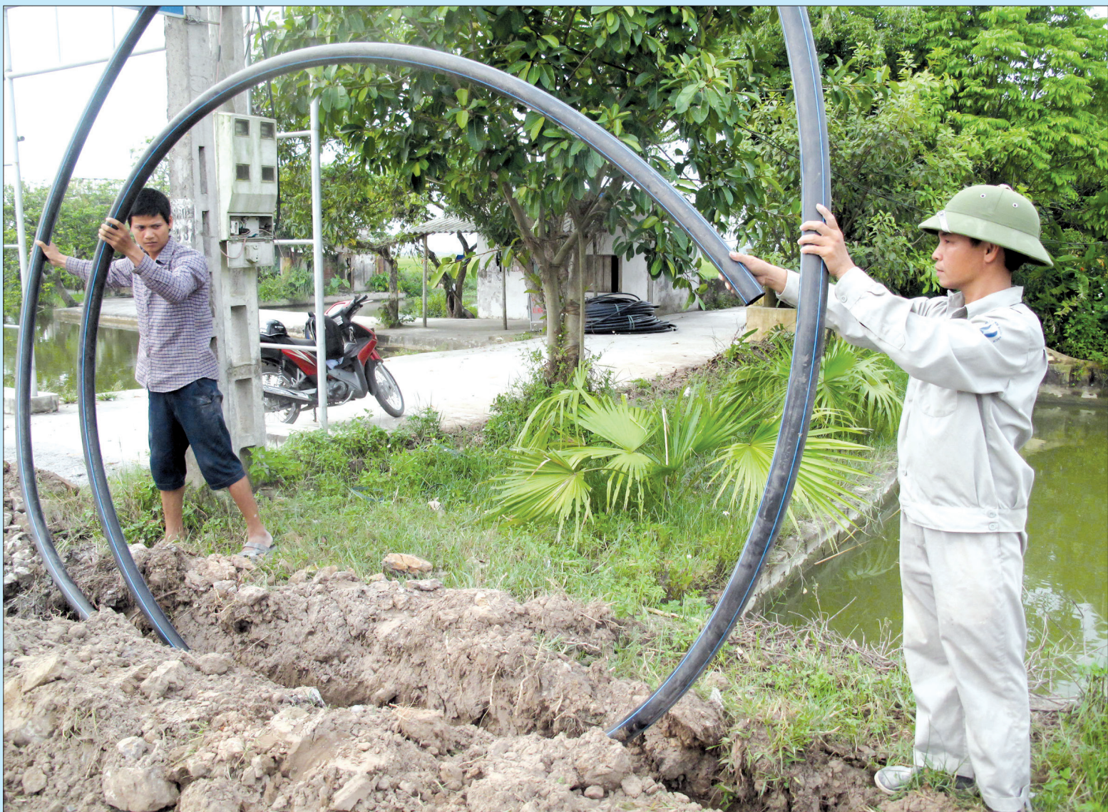
Công ty Cổ phần Nước sạch Hưng Hà lắp đặt đường ống dẫn nước.
