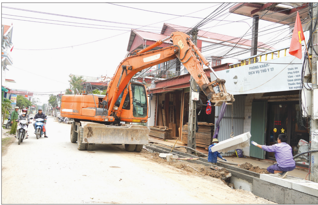
Dự án đường ĐH.86 xã Thụy Chính đến xã Thụy Ninh phấn đầu tháng 6/2026 sẽ hoàn thành.
