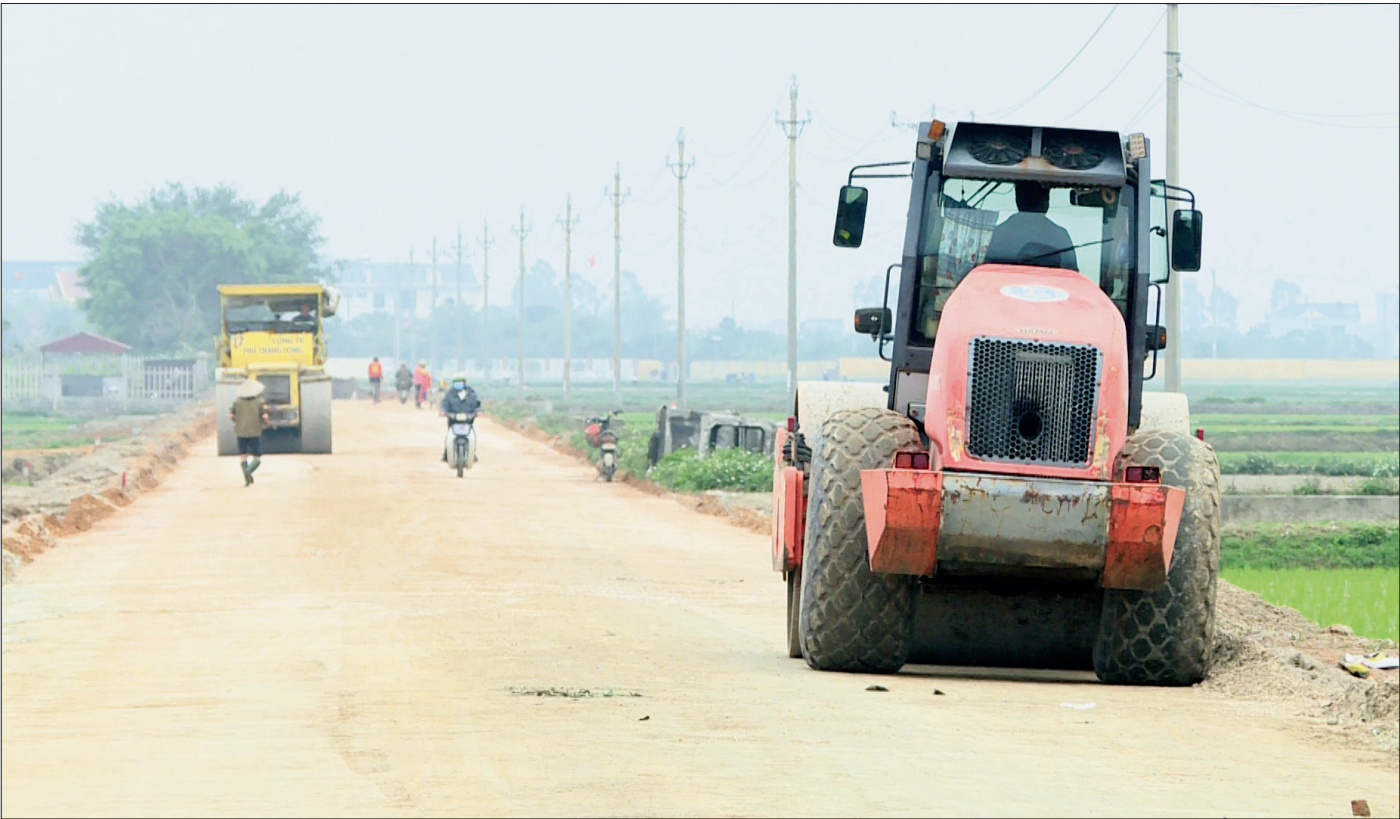
Dự án đường ĐH.96 xã Dương Phúc đi xã Thụy Duyên (giai đoạn 2) đang được nhà thầu gấp rút thi công.
