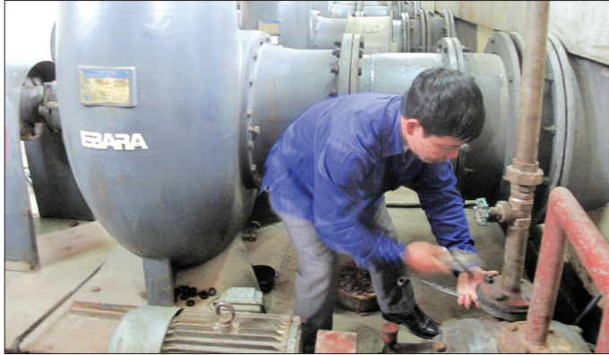
100% máy bơm được Công ty TNHH Một thành viên Khai thác công trình thủy lợi Nam Thái Bình tu sửa, bảo dưỡng để đáp ứng nhu cầu tưới, tiêu phục vụ sản xuất vụ mùa,
