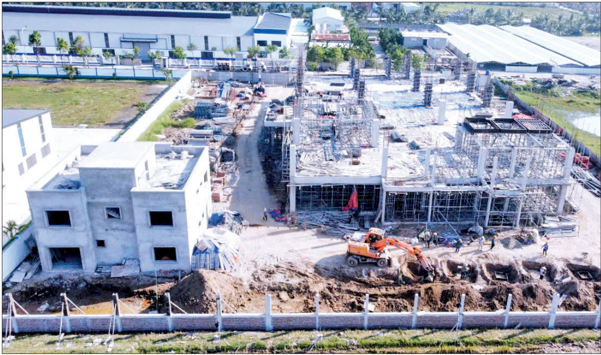
Công ty TNHH LeBao Technology đang xây dựng nhà máy, dự kiến tháng 5/2025 sẽ đi vào hoạt động.
