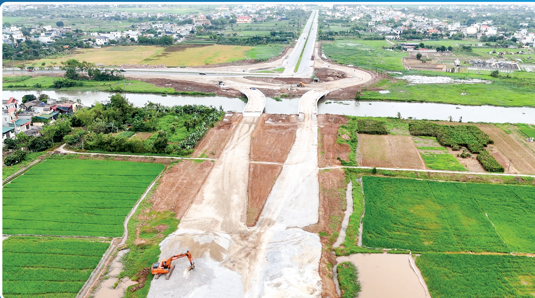
Cầu Kiến Giang thuộc địa phận xã Vũ Chính (thành phố Thái Bình) đang thi công hoàn thiện phần đường dẫn chân cầu.
