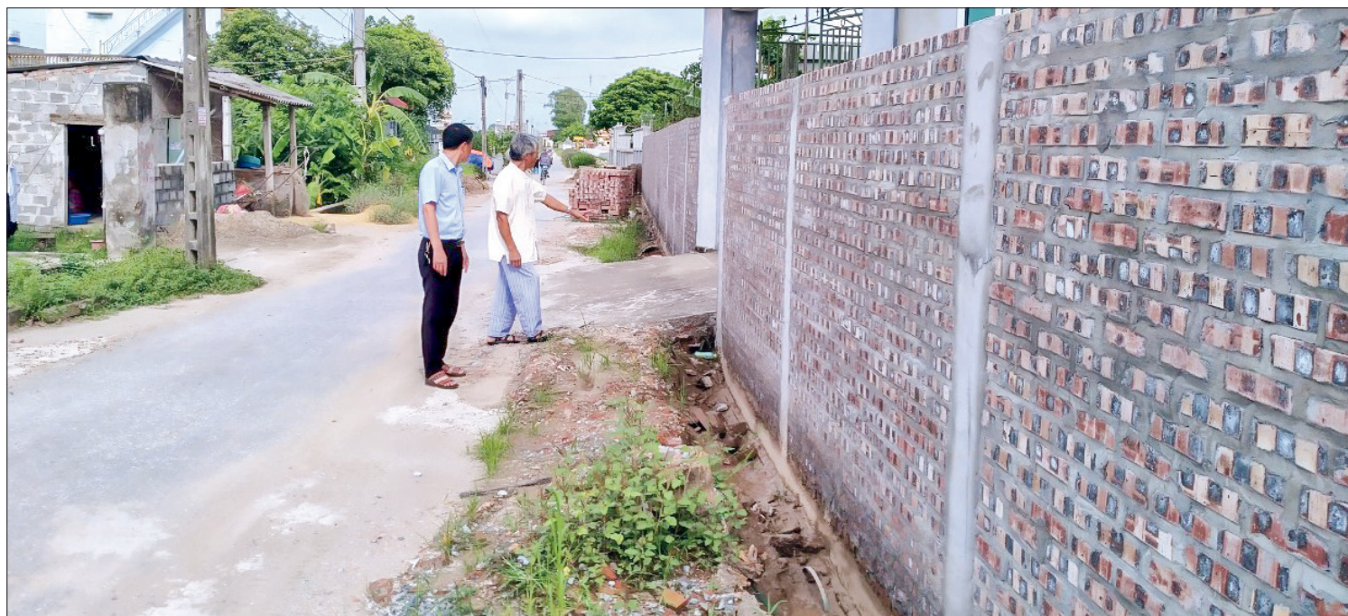
Mặc dù công trình chưa khởi công song gia đình ông Lưu Ngọc Lương (người áo trắng), thôn Tống Xuyên, xã Thái Hưng (Hưng Hà) đã tự nguyện phá dỡ tường bao, cây cối bàn giao mặt bằng để việc thi công tuyến đường được thuận lợi.
