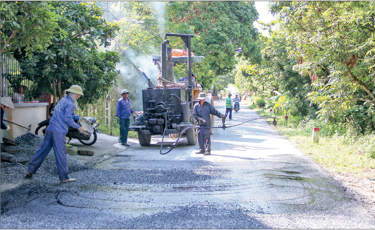
Duy tu, bảo dưỡng tuyến đường ĐT.454 đoạn qua khu Thọ Mai, thị trấn Hưng Hà (Hưng Hà).
