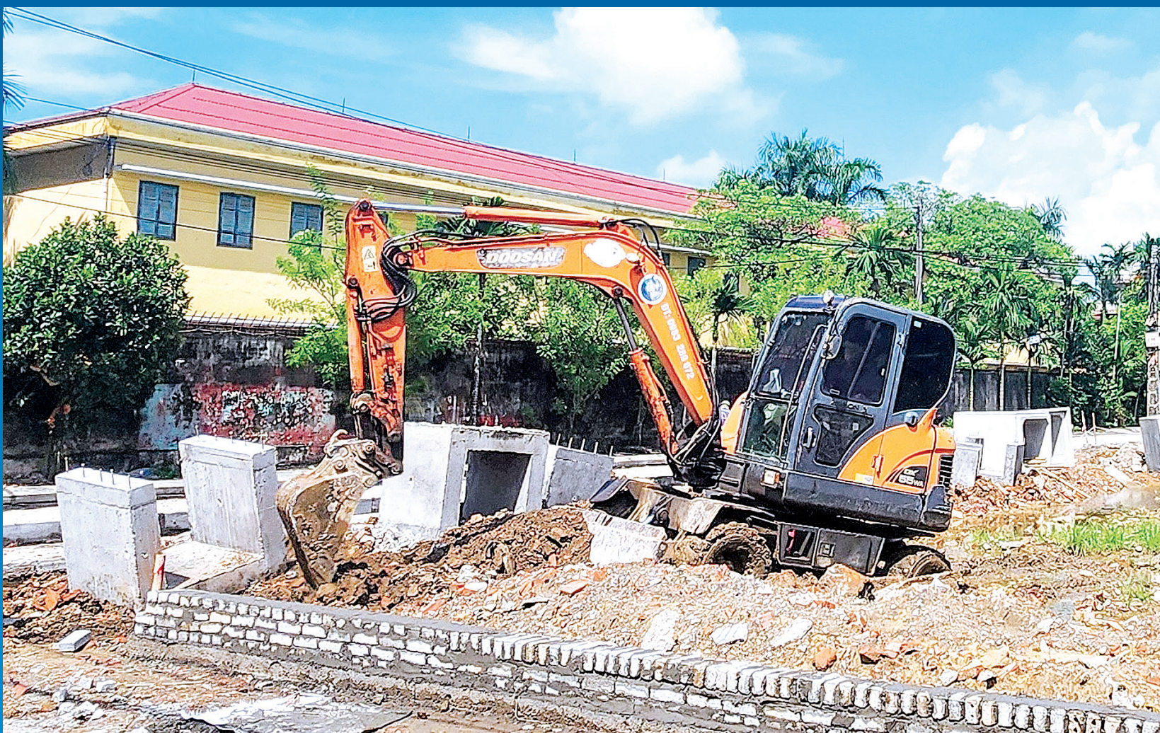
Thi công hạ tầng khu dân cư thuộc phường Phú Khánh (thành phố Thái Bình).
