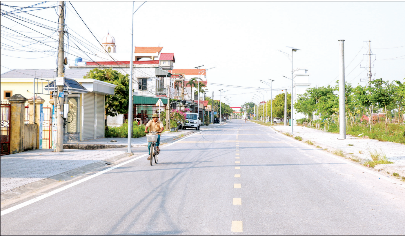
Nhờ thực hiện tốt công tác kiểm tra, giám sát, các công trình trên địa bàn xã Tây Ninh (Tiền Hải) đều bảo đảm tiến độ, chất lượng.
