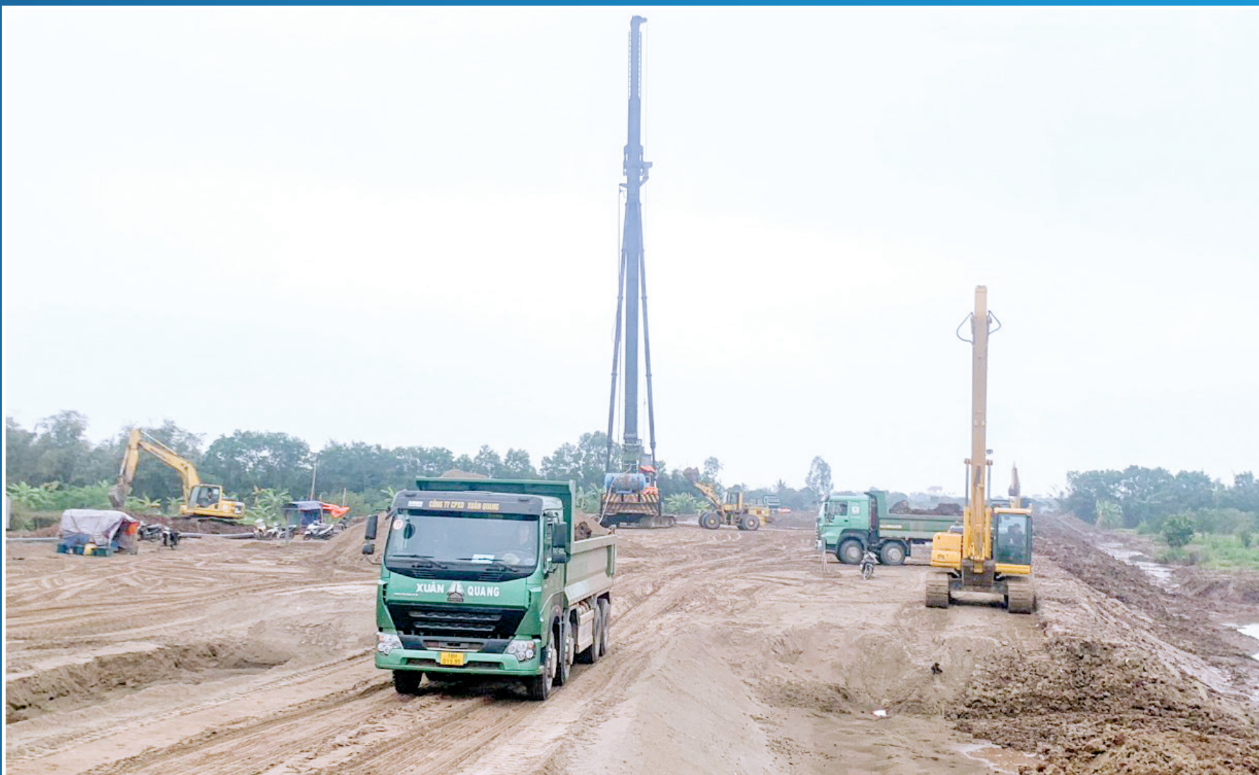
Thi công tuyến đường trục kết nối các khu chức năng trong Khu kinh tế Thái Bình, đoạn qua địa bàn xã Nam Hải (Tiền Hải).
