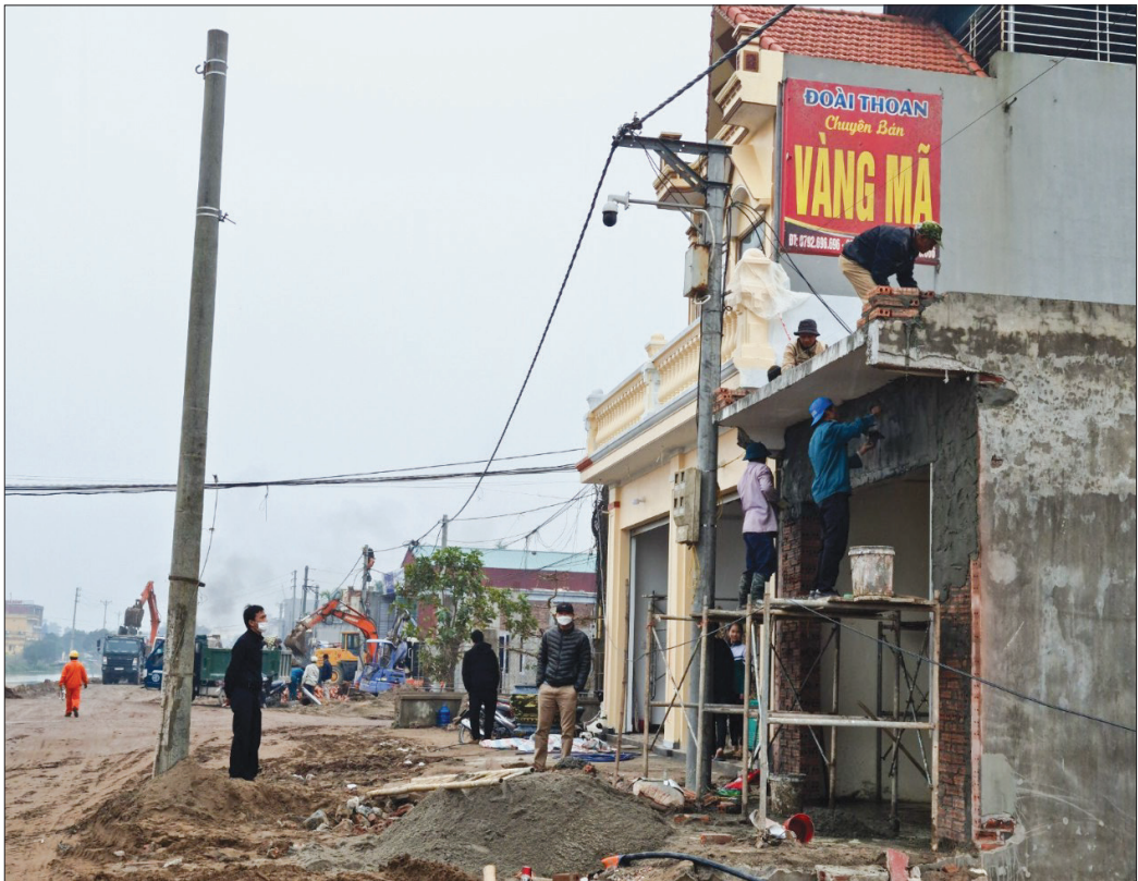
Người dân xã Nam Chính phá dỡ các công trình, bàn giao mặt bằng thi công tuyến đường 221A.
