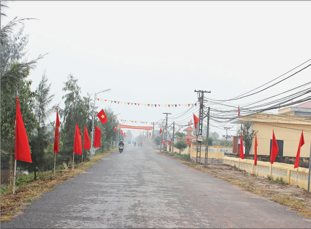
Đường giao thông nông thôn xã Tây Phong (Tiền Hải).
