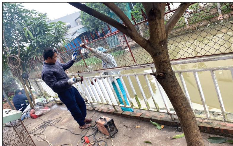
Người dân xã Minh Lăng tự giác tháo dỡ tường bao, cổng đầu xây dựng vi phạm hành lang bảo vệ công trình thủy lợi sông Cự Lâm.
