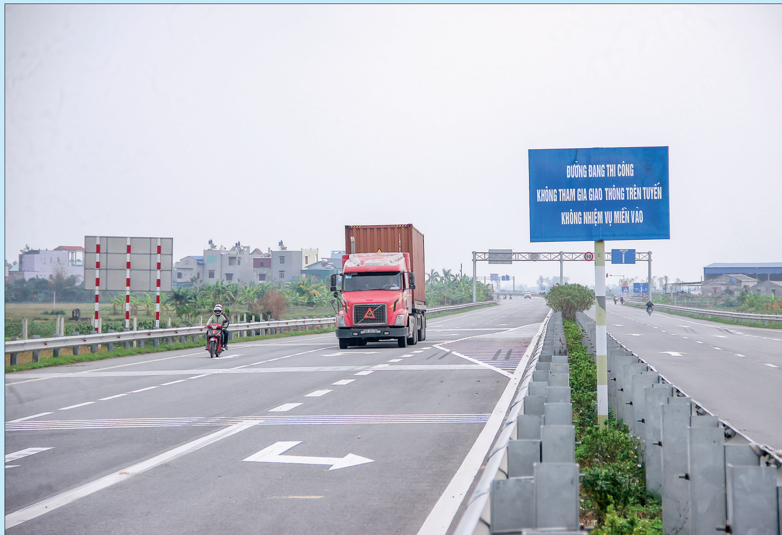
Mặc dù đã có biển báo hiệu "Đường đang thi công, không tham gia giao thông trên tuyến" nhưng vẫn có rất nhiều phương tiện lưu thông trên tuyến đường Thái Bình - Hà Nam.
