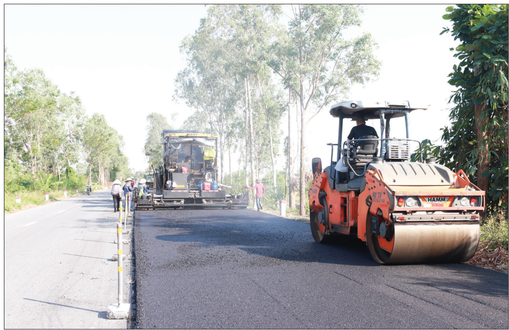
Sửa chữa quốc lộ 39, đoạn từ Km64+00-Km74+400.
