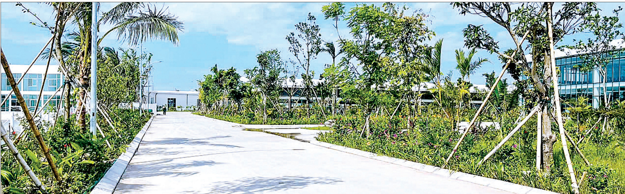
Hạ tầng cụm công nghiệp Thống Nhất được xây dựng khang trang, hiện đại.
