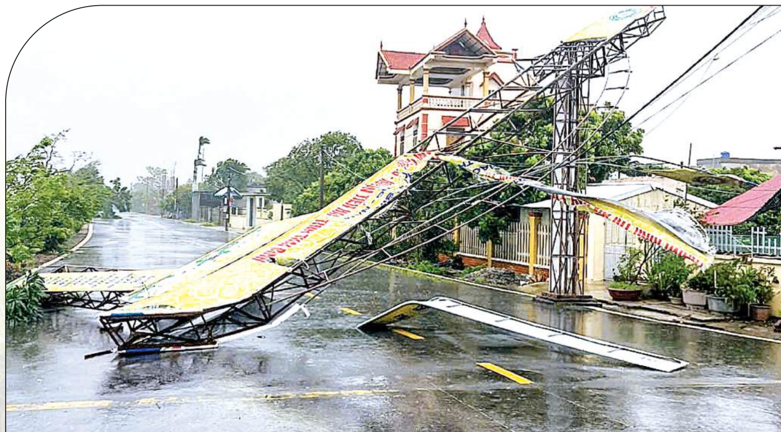
Cổng chào tại xã Nam Cường (Tiền Hải) sập đổ do bão số 3.
