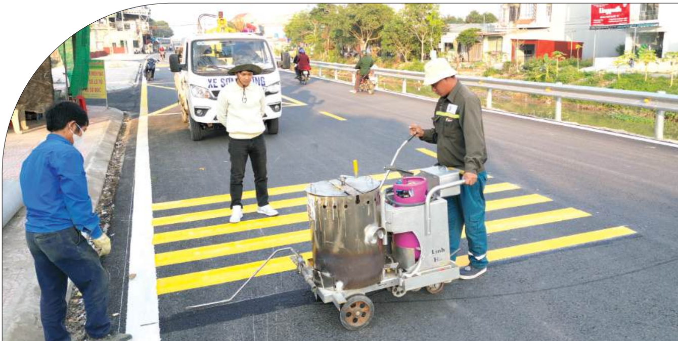
Thi công hệ thống vạch kẻ đường tuyến đường tỉnh ĐT.452 (đường 224) đoạn từ đường Thái Bình - Hà Nam đến xã Dân Chủ (Hưng Hà).
