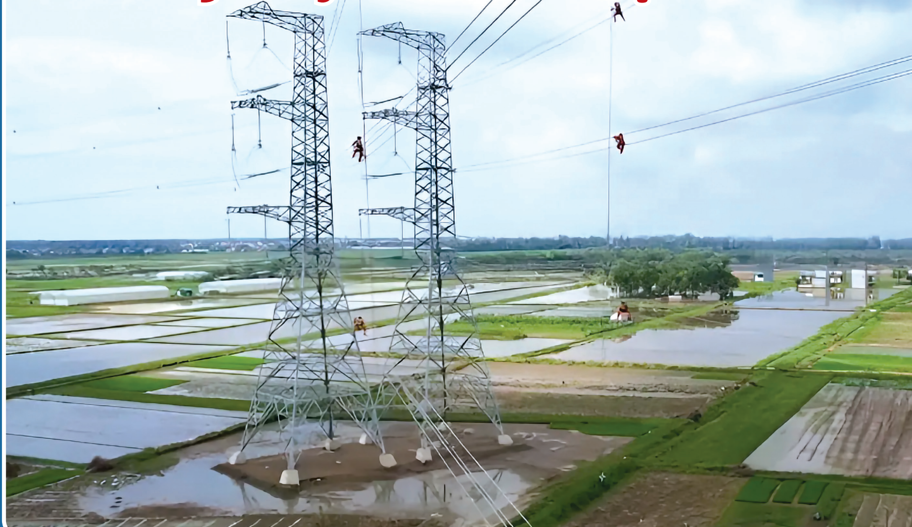
Trên địa bàn tỉnh Thái Bình có 107 vị trí móng cột đường dây 500kV mạch 3.
