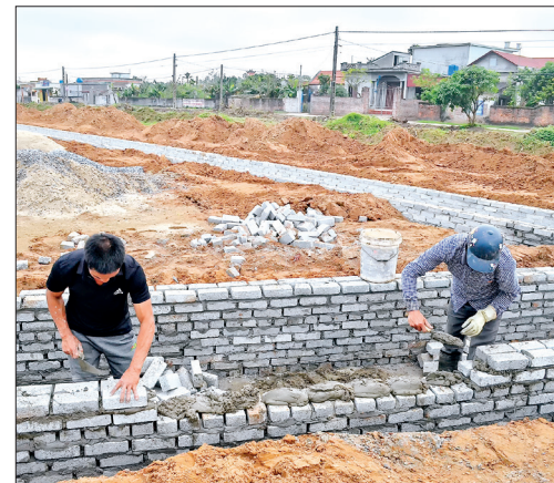
Đầu tư xây dựng hạ tầng khu dân cư xã Thái Thượng (Thái Thụy).
