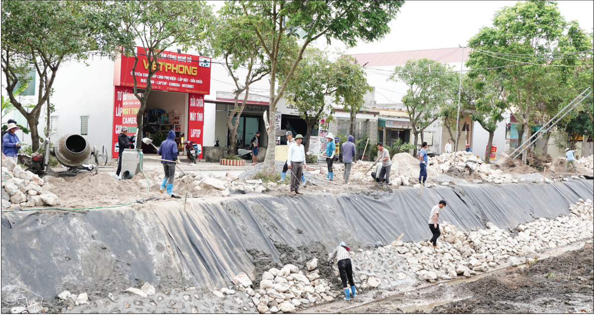
Xã Đồng Phương tiến hành cải tạo bờ kè sông trực để hoàn thiện tiêu chí xây dựng nông thôn mới kiểu mẫu.
