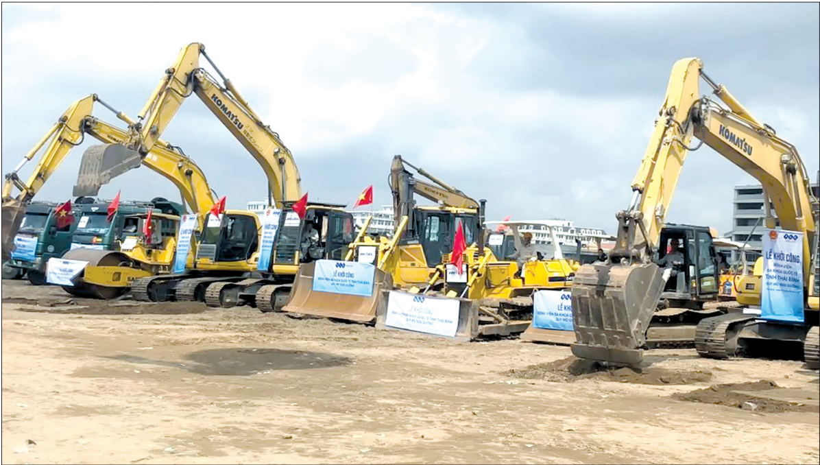
Bệnh viện Đa khoa Quốc tế tỉnh Thái Bình quy mô 1.000 giường đã được khởi công xây dựng.
