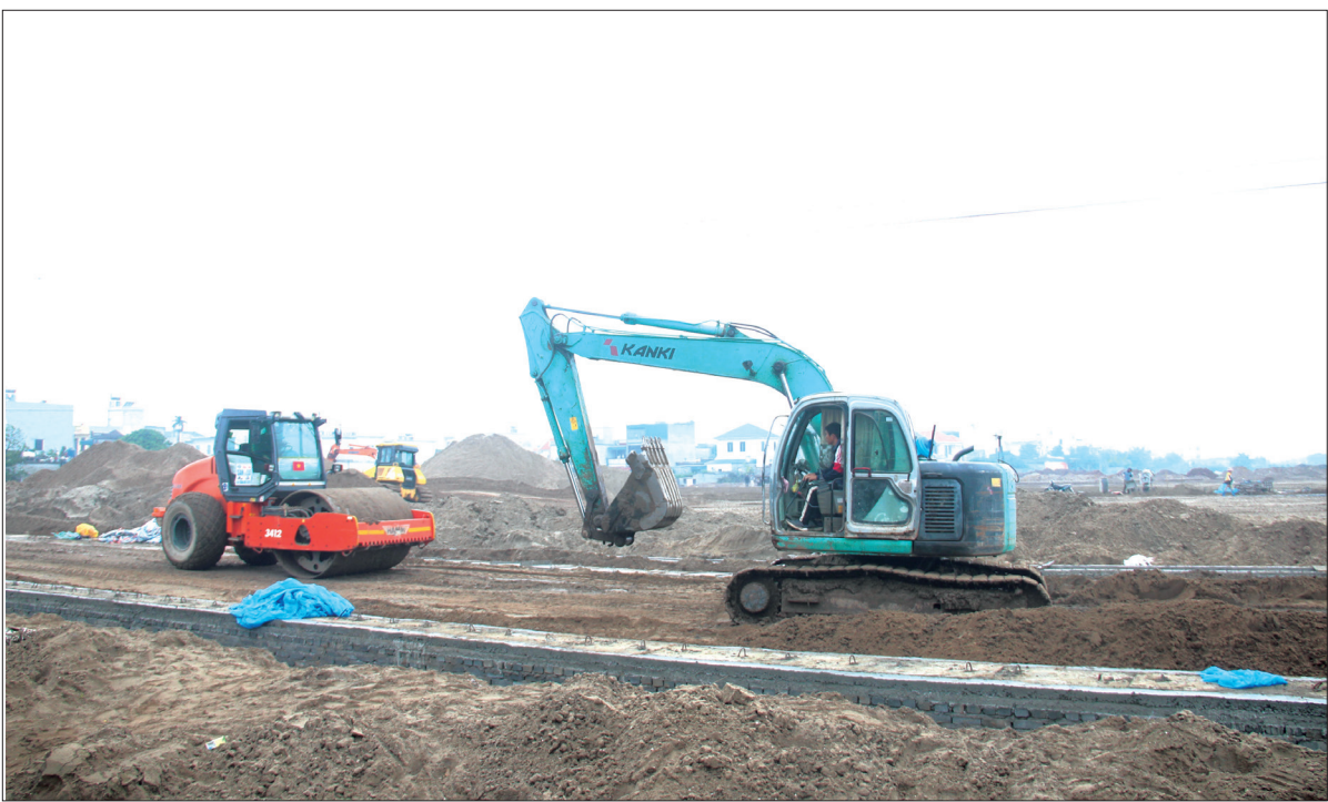
Thi công dự án hạ tầng kỹ thuật khu dân cư tại khu đất nông nghiệp thôn Thanh Miếu, xã Vũ Phúc.
