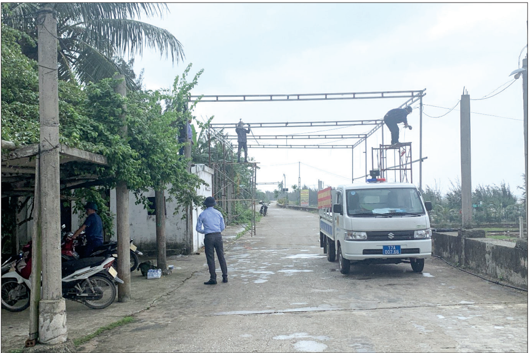
Hộ dân xã Đông Minh tháo dỡ mái che, mái vẩy trên tuyến đê biển số 6.
