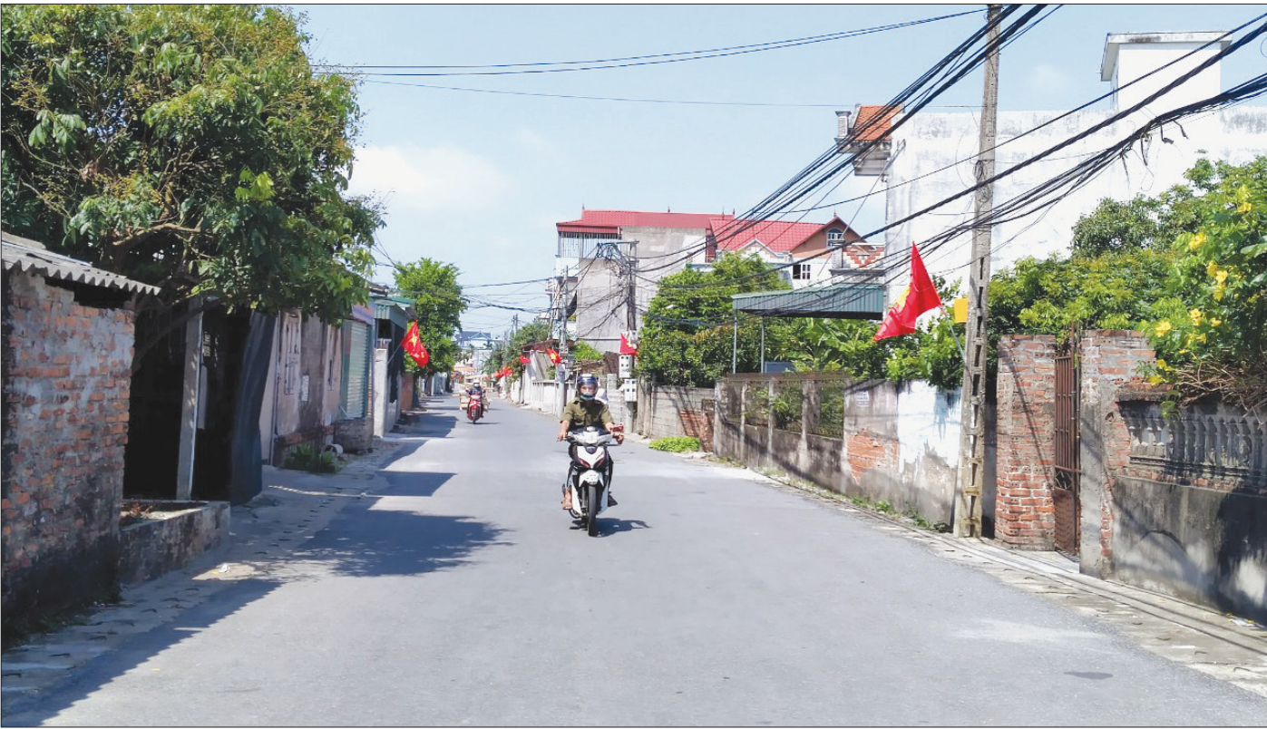
Hệ thống đường giao thông của xã Vũ Đông (thành phố Thái Bình) được đầu tư xây dựng đồng bộ, đáp ứng nhu cầu đi lại của người dân.
