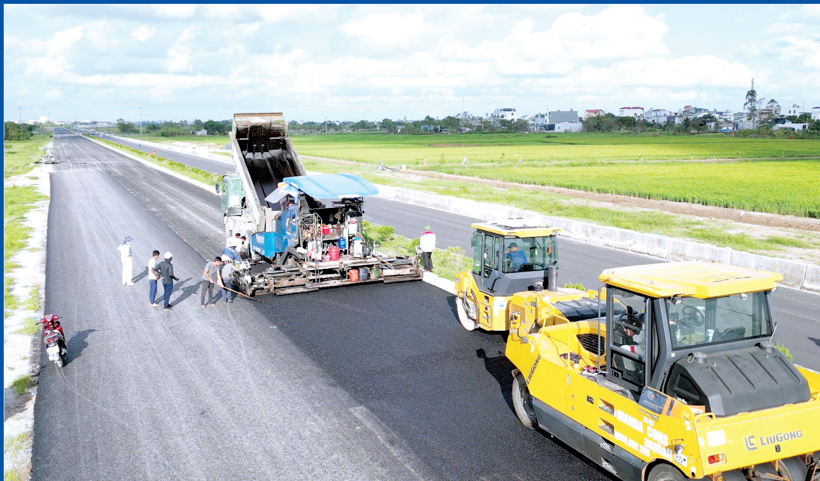
Đơn vị thi công đường vành đai phía Nam thành phố đang nỗ lực đẩy nhanh tiến độ tại các vị trí đã được bàn giao mặt bằng nhằm thúc đẩy giải ngân nguồn vốn đầu tư của dự án.
