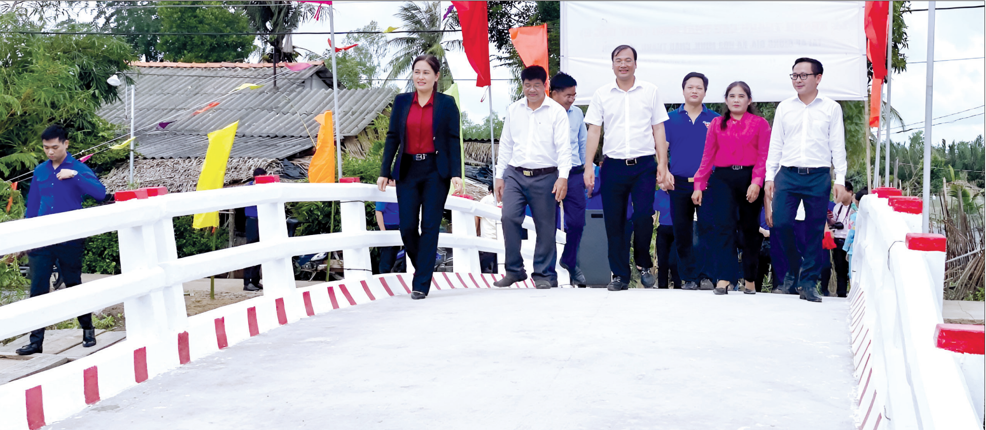
Cầu Thái Bình (Mây Dốc 2) tại ấp Giồng Giá, xã Minh Hòa, huyện Châu Thành (Trà Vinh).
