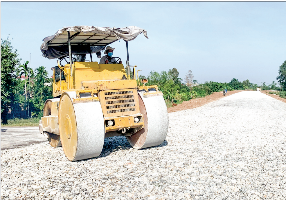
Thi công lu nền, cấp phối đá dăm đê tả Trà Lý đoạn từ K2+900 đến K6+600.
