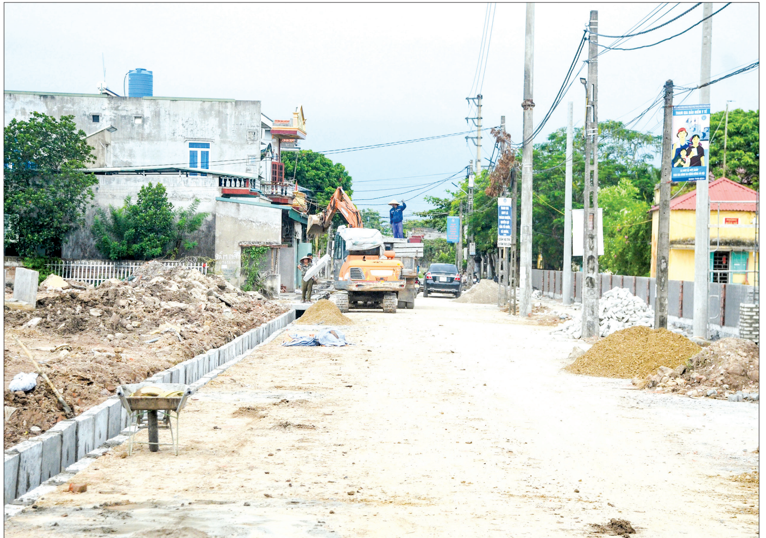
Nhân dân xã Quỳnh Hoa hiến đất mở rộng đường giao thông.
