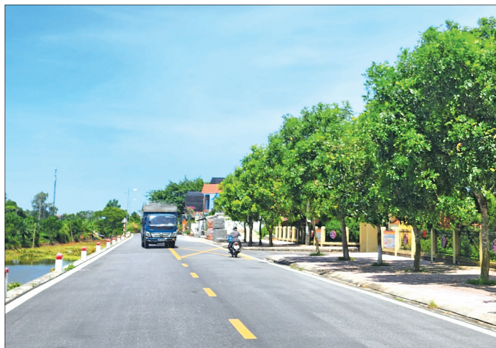
Nhờ làm tốt công tác giải phóng mặt bằng, hạ tầng giao thông xã Duy Nhất (Vũ Thư) được đầu tư đồng bộ.
