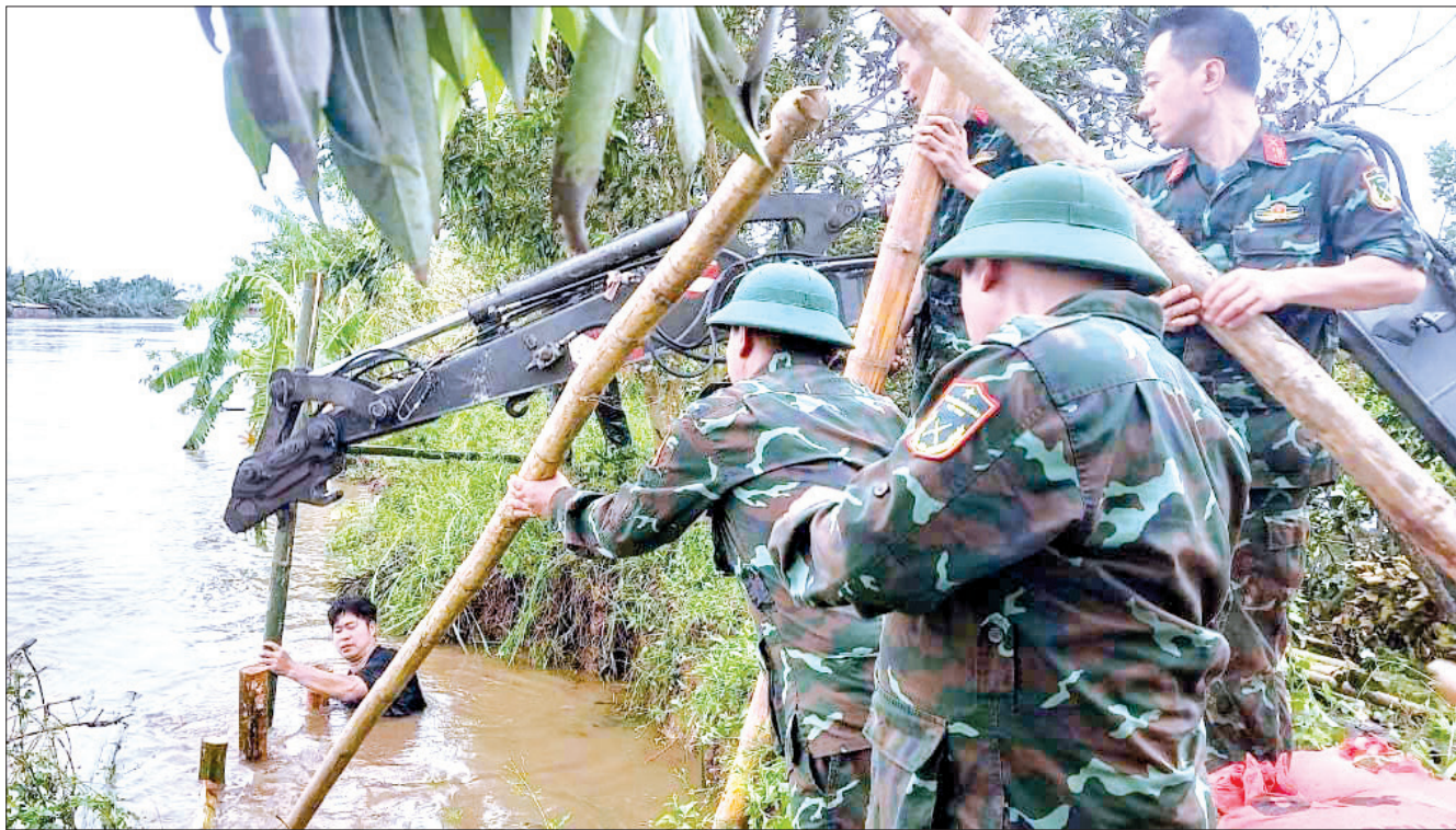
Ban CHQS huyện Vũ Thư gia cố các tuyến đê xung yếu trên địa bàn xã Vũ Văn trong bão số 3 năm 2024.
