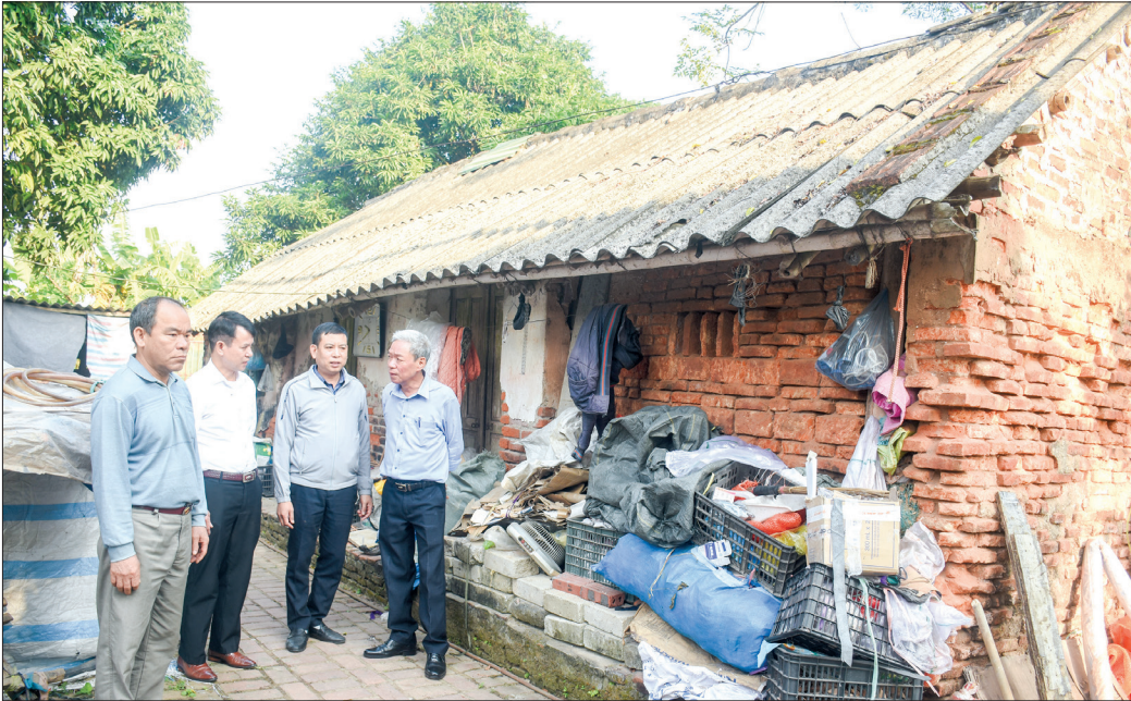
Tỉnh Thái Bình có 2.106 hộ nghèo và cận nghèo cần được xây mới hoặc sửa chữa về nhà ở.
