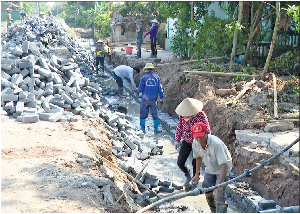
Thi công đường ĐH.78, đoạn qua địa bàn xã Quỳnh Ngọc (Quỳnh Phụ).
