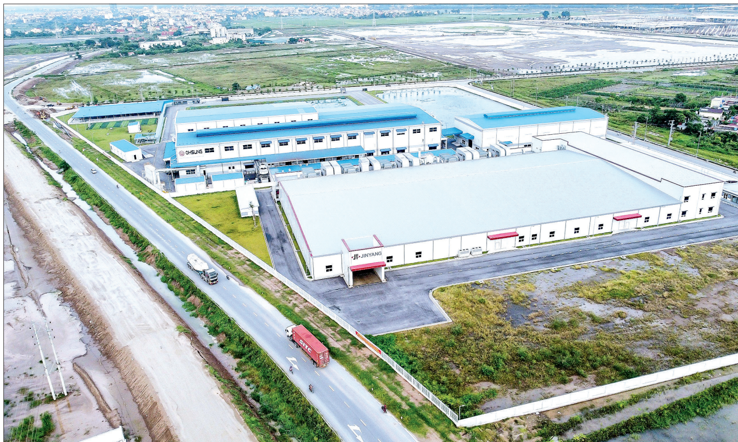
Khu công nghiệp Liên Hà Thái (Thái Thụy) cơ bản hoàn thành công tác giải phóng mặt bằng.
