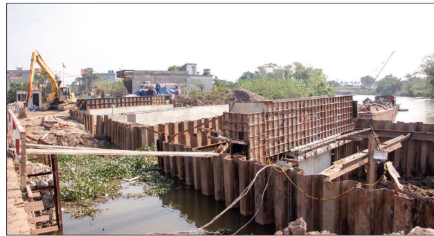
Cầu Đò Mèn đang trong quá trình thi công, phần đầu thông cầu trước tết Nguyên đán Canh Tý 2020.
