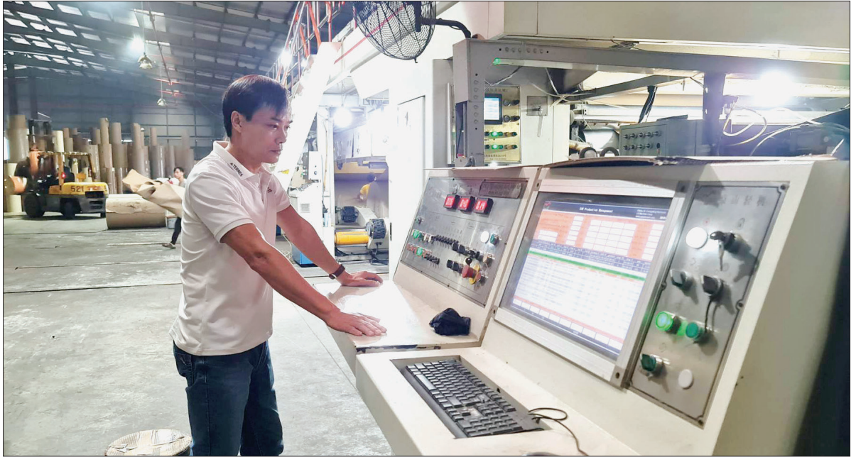
Công ty TNHH Phúc Kiến (cụm công nghiệp Vũ Ninh, huyện Kiến Xương) luôn chú trọng bảo đảm an toàn điện trong sản xuất.
