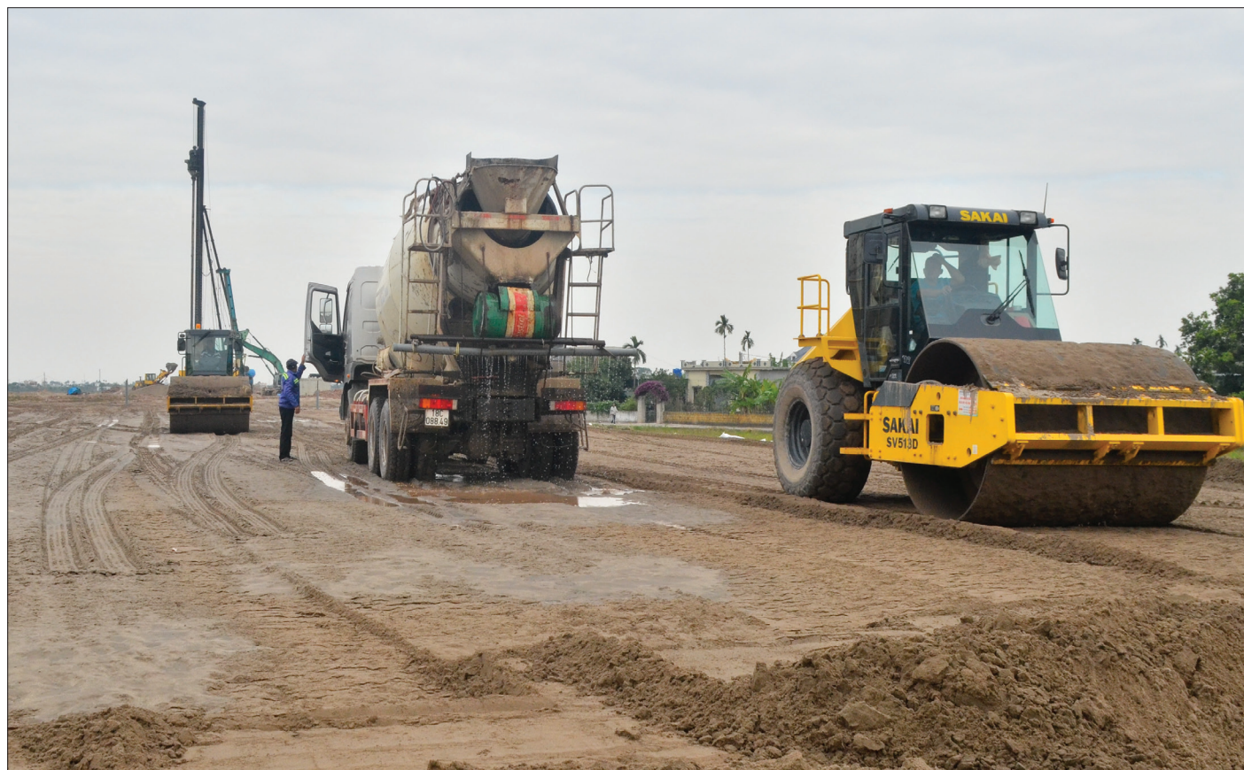
Thi công tuyến đường trục phía Nam Khu kinh tế Thái Bình, đoạn qua huyện Kiến Xương và Tiền Hải.
