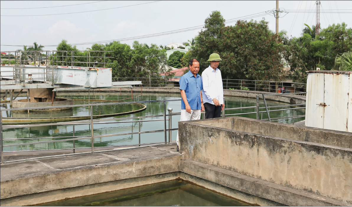
Lãnh đạo Công ty Cổ phần Nước sạch Thái Bình kiểm tra khu vực bể sơ lắng và bể lọc sơ bộ.
