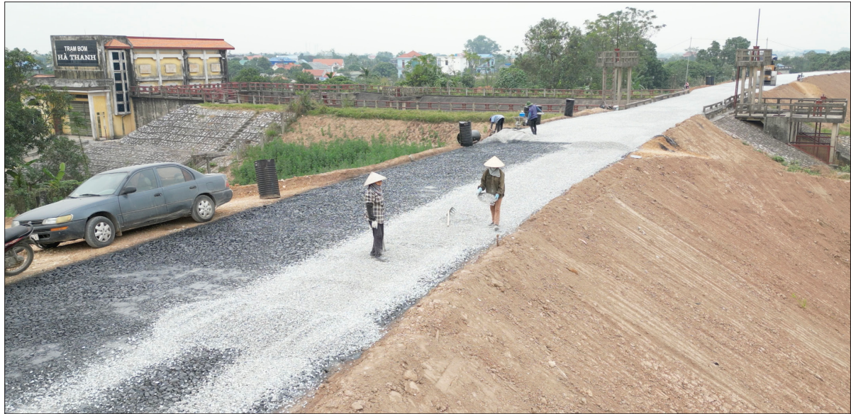
Gia cố, cải tạo mặt đê hữu Luộc địa phận huyện Hưng Hà.
