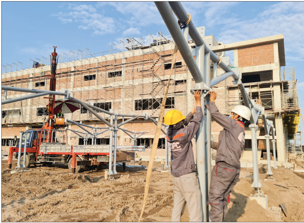
Công nhân tập trung cao độ thi công các hạng mục cuối cùng của dự án nhà máy Goodway Việt Nam.
