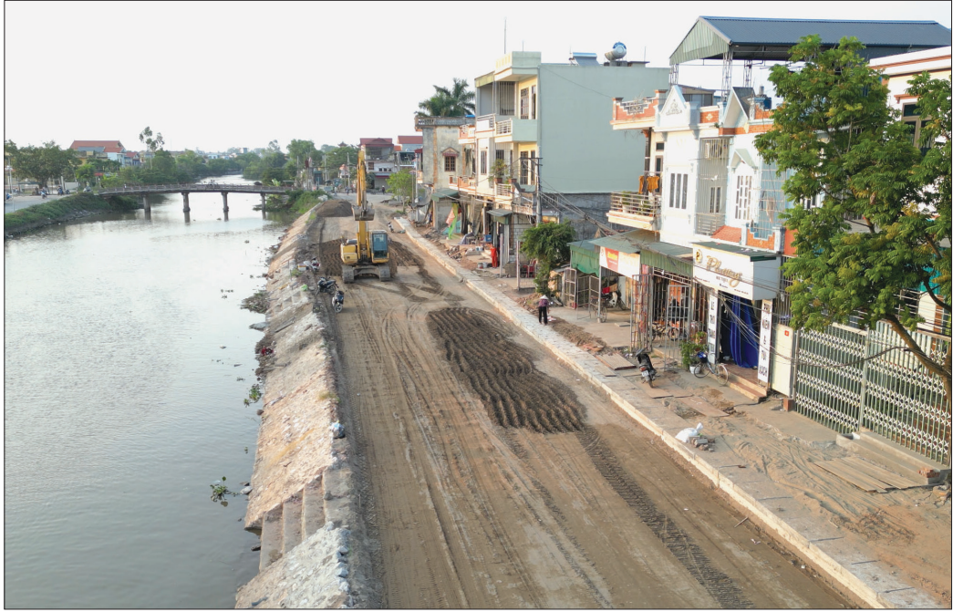
Thi công nền đường dự án cải tạo, nâng cấp đường cứu hộ, cứu nạn liên xã Quang Bình, Quang Minh, Minh Tân, Bình Thanh.
