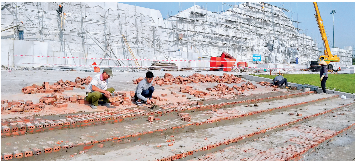
Các công việc còn lại đang được gấp rút hoàn thành.
