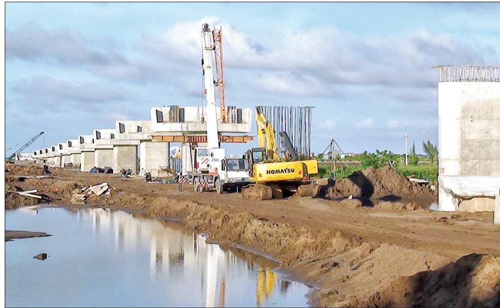
Công trình cầu sông Hồng thuộc dự án tuyến đường bộ ven biển tỉnh Thái Bình đang được đẩy nhanh tiến độ thi công.
